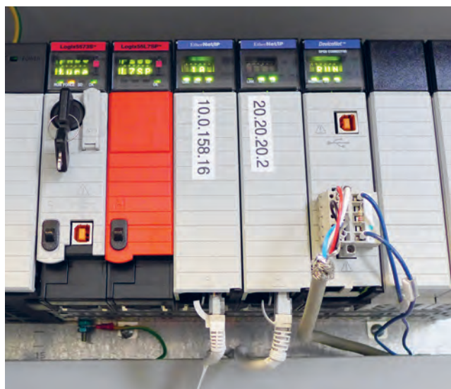
PLC med et enkelt sikkerhedsmodul. Sikkerhedsrelæer og sikkerheds-PLC'er har normalt en anden farve, gerne rød eller gul. Men kontroller alligevel dokumentationen for at være helt sikker.
