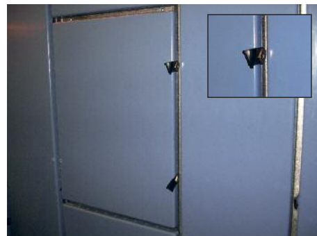
El-tavle som kan åbnes uden brug af værktøj.
