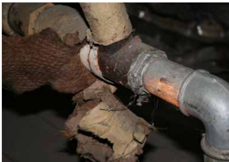
Asbestpap anvendt som teknisk isolering. Asbestpap er typisk lagt som inderste lag, direkte på røret.
