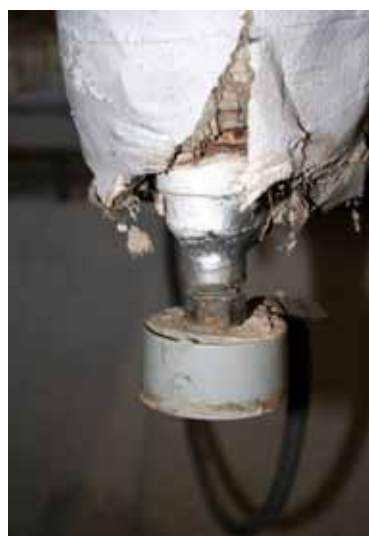
Asbestholdig kiselgur er typisk anvendt ved rørbøjninger, flanger, hanestykker, termometerudtag samt på pletter og beholdere.
