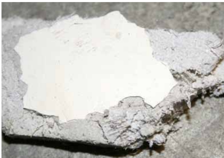
Asbestsilikatplade. Pladetypen er genkendelig, idet den er forholdsvis blød (sprød) og let at knække. Stor anvendelse af denne pladetype har fundet sted på skibe.
