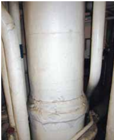
Aftræksrør fra dieselmaskine. Isolering med hvid asbest er intakt.
