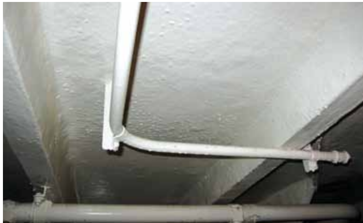
Skibsloft med sprøjteasbest og glat malingsforseglet overflade.
