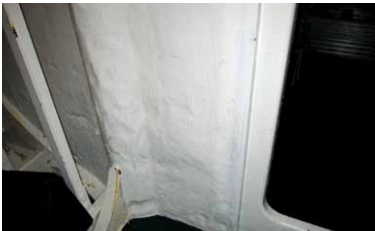
Skot med hvid asbest. Ingen huller – fuld malingsforsegling og væv.
