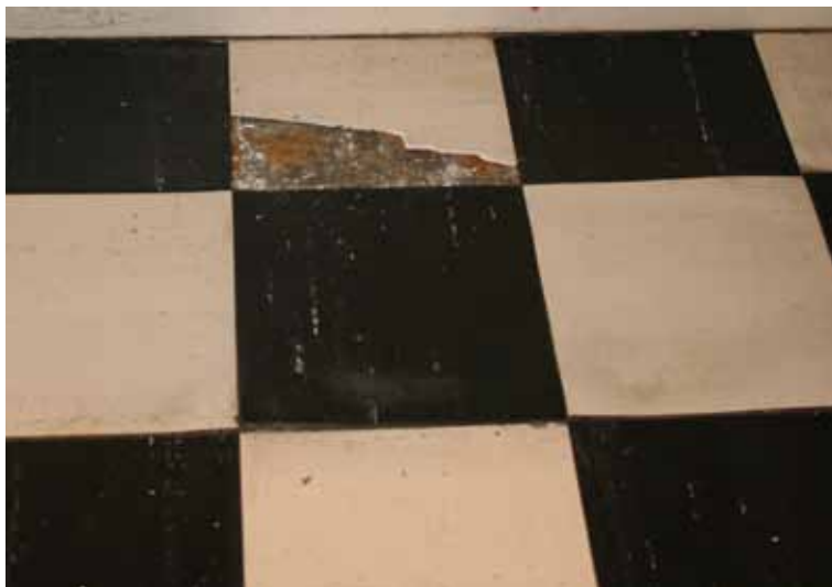
Vinylbelægning. Asbest har været anvendt som forstærkning i vinyl.
