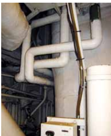
Små rørdimensioner med asbest både på lige stræk og i bøjninger. Husk sidstnævnte er hårde som "sten" og kan ikke trykkes ved fingerkræfter (test).
