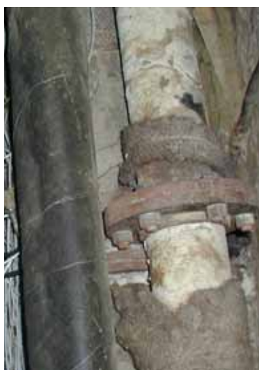
Asbestpap ses oftest anvendt under ældre isoleringstyper som fx. filt.
