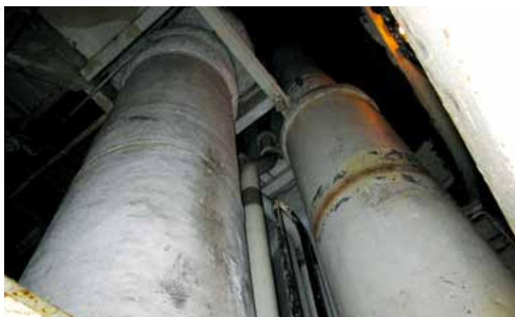
Et overblik over forholdene i det indre af casingen i et skib med to forseglede og asbestisolerede aftræksrør fra dieselmotorer.
