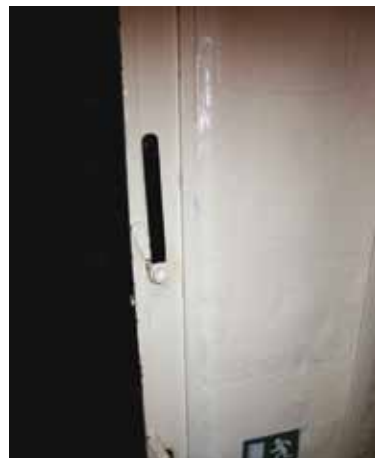
Skot med hvid asbest. Overflade med lærred og bemaling i høj glans. Asbesten er forsegleet tilfredsstillende.
