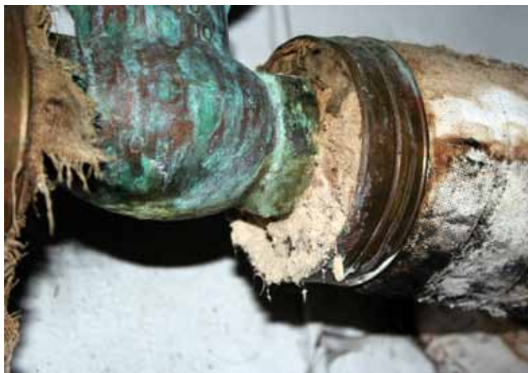
Teknisk isolering bestående af kiselgur med asbest ses ved uforseglet afslutning.
