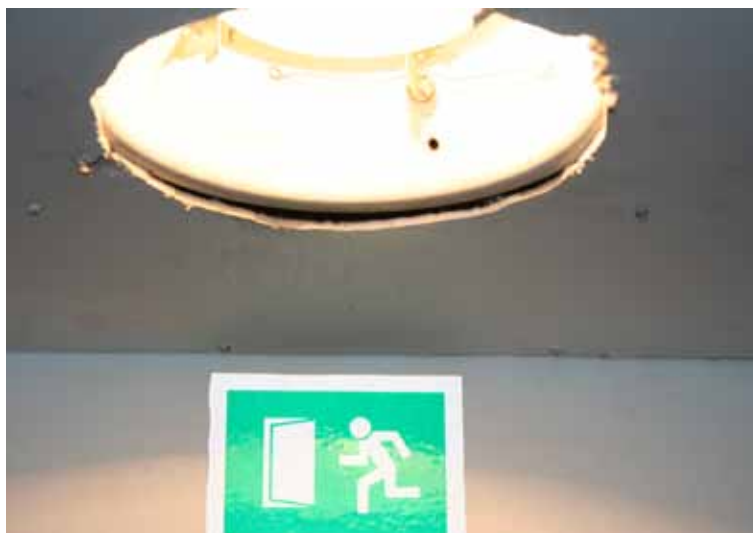
Loftsplade af asbestsilikat gennemboret til installation af ovenlys. Asbestsilikat er typisk anvendt som brandsikring omkring aftræk fra motor og under broen.
