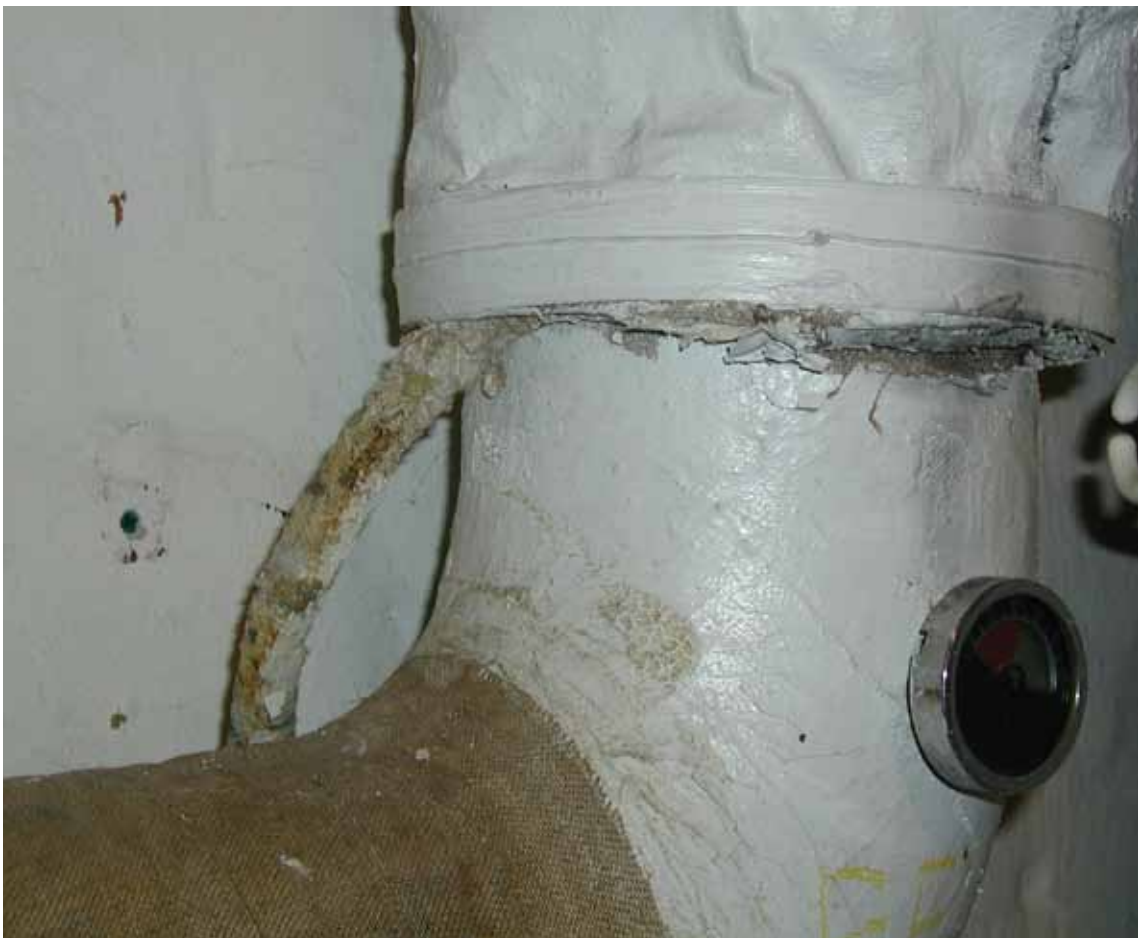
Uforseglet asbestsnor som har revet sig fri af den øvrige isolering. Dette medfører stor fare for kontaminering.
