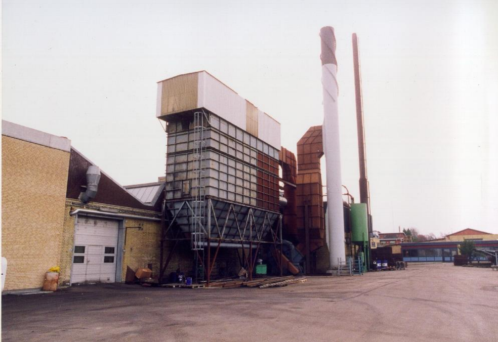
Figur 6: Sandbunkere til nyt og regenereret sand, og filtre på et bronzestøberi
