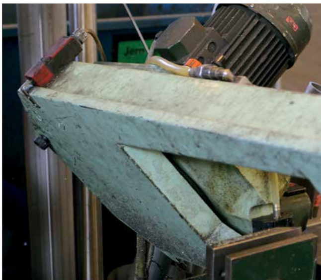
Eftermonteret lågkontakt på metalsaven.
