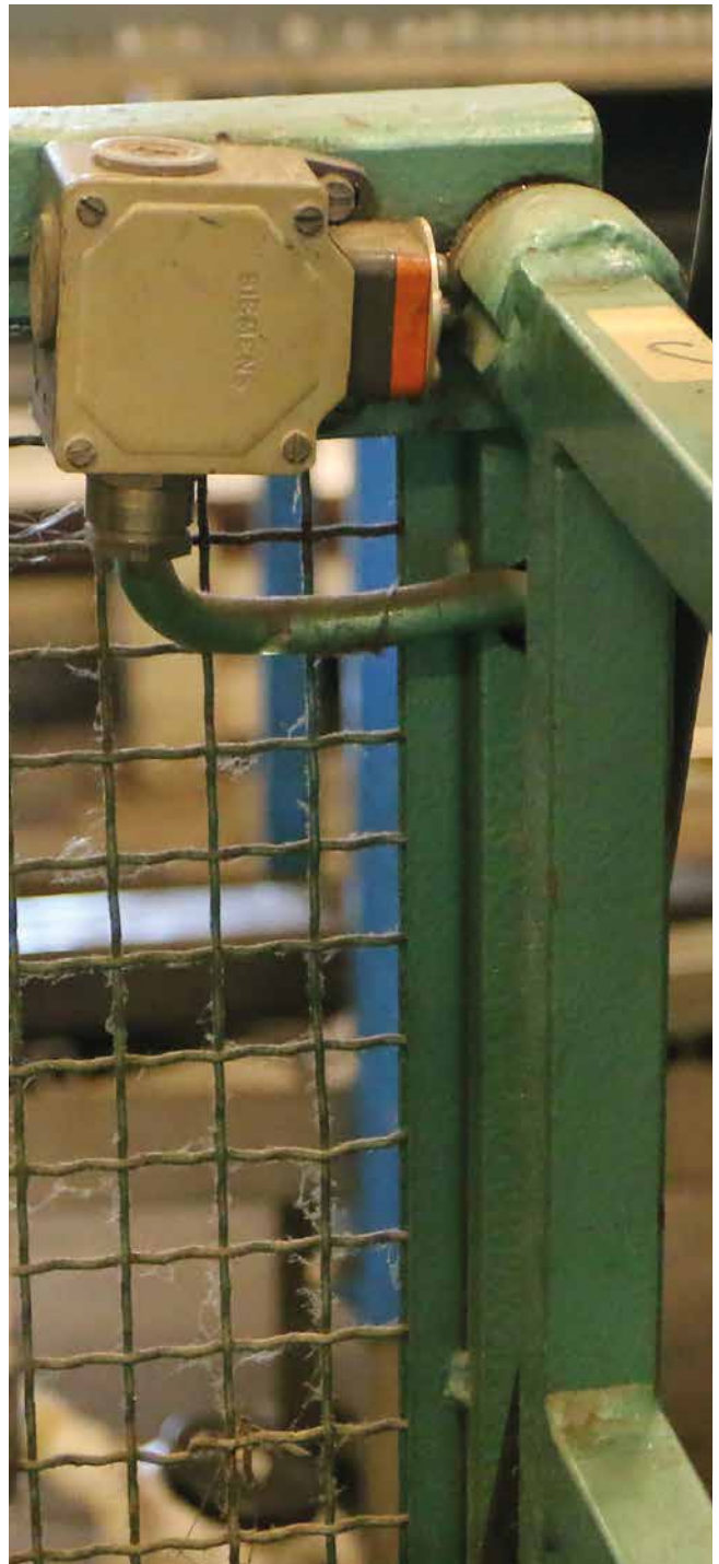
Låge med sikkerhedsafbryder ved pressens bagside.
